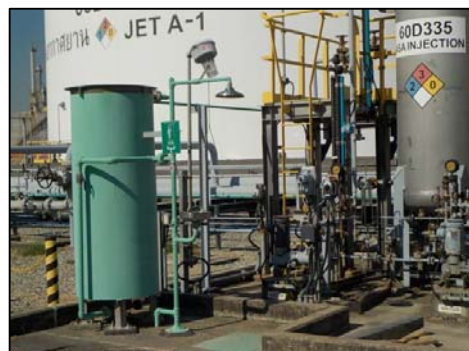
รูปที่ 3-35 ฝักบัวและอ่างล้างตาฉุกเฉิน
