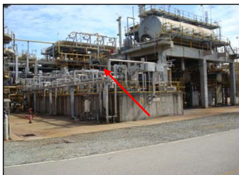
รูปที่ 3-10 ระบบดูอากาศจากบ่อซัลเฟอร์
